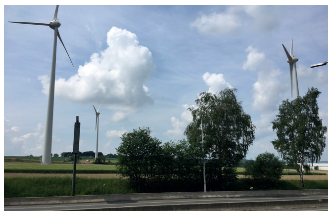
Parc éolien d'Assesse (Source : econova.com)
